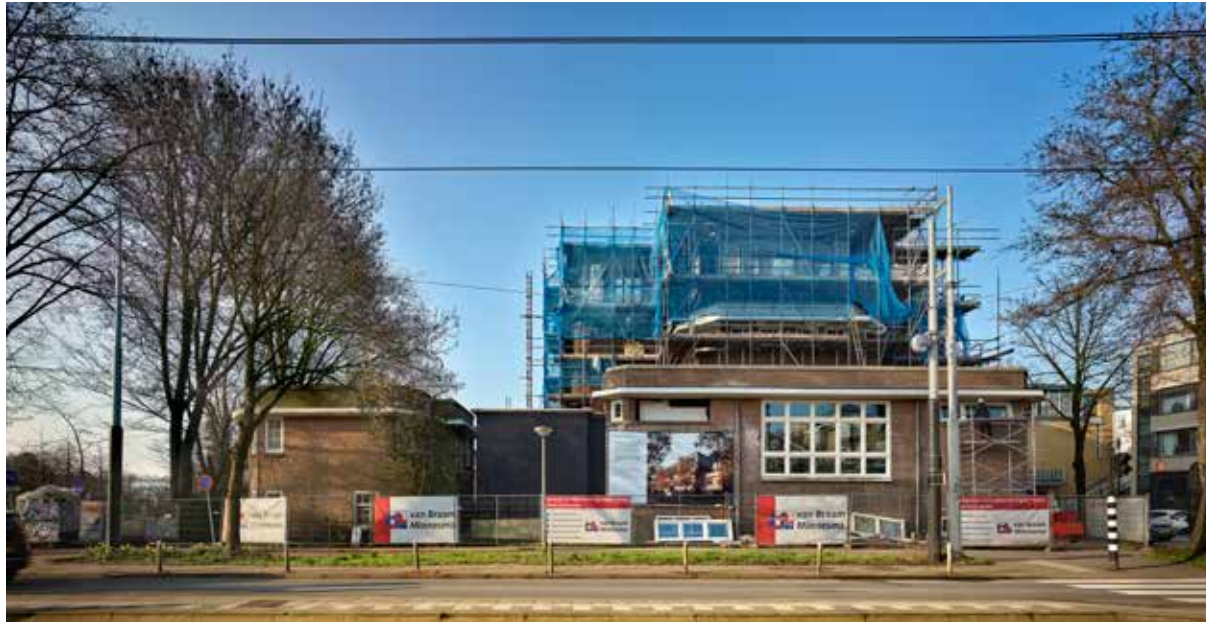
Op de bovenverdieping is een opbouw gekomen die het gebouw anderhalf keer zo hoog maakt
